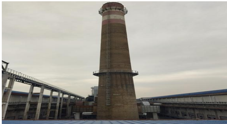
Şəkil 3.1.4. GAK-da zərərli kimyəvi maddələri təmizləyən filtrasiya borusu
